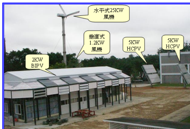
圖 11/核能研究所智慧型直流電力屋
