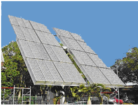
圖 5/核研所 5 kW 聚光型太陽能發電系統 圖 6/南科高雄園 1 百萬瓦級高聚 光型太陽光發電系統
